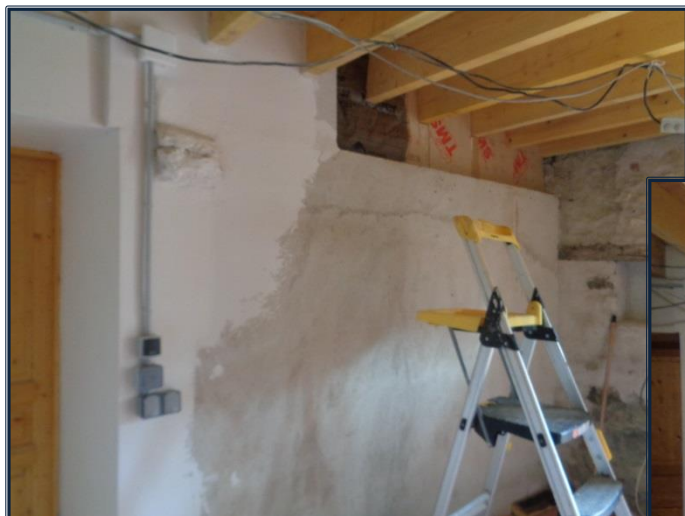
Achèvement du doublage avec début du câblage électrique
